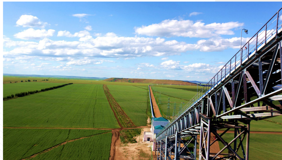
图：金新化工输煤长输送栈桥
